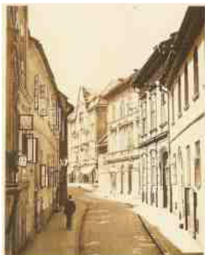
Widok z lat 1920-29, kamienice widoczne po prawej stronie, z wyjątkiem ostatniej, zostały wyburzone w roku 1972, podczas budowy mostu na Białej.
