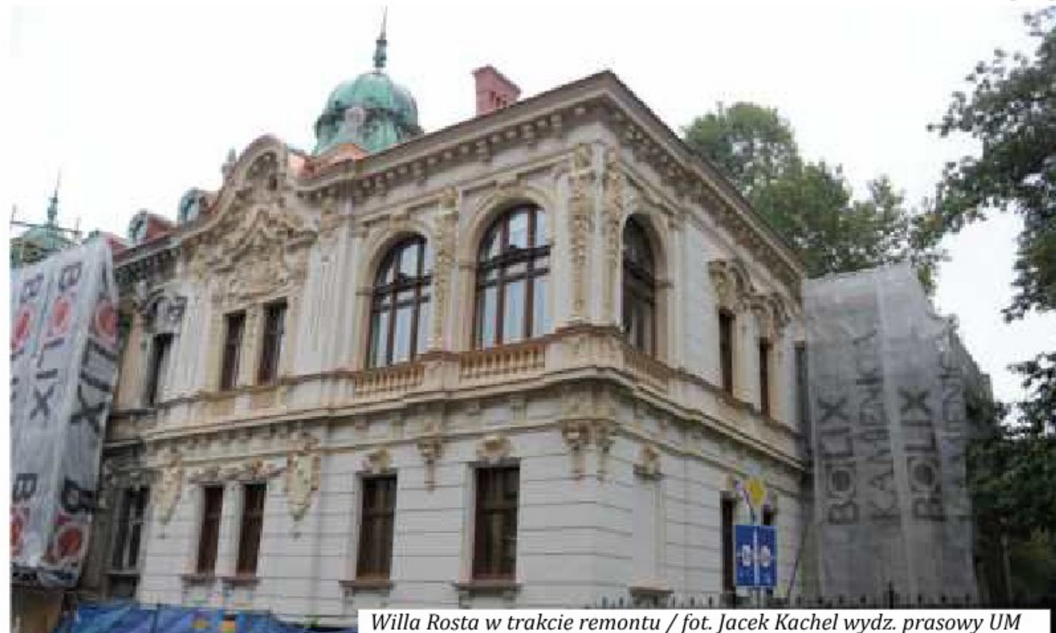
Willa Rosta w trakcie remontu / fot. Jacek Kachel wyd. prasowy UM
